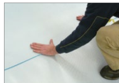
(3) Een goede afdichting van de overlapping verzekeren
