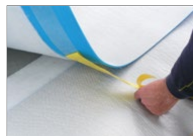
(2) De beschermstrip van de zelfklevende band verwijderen
